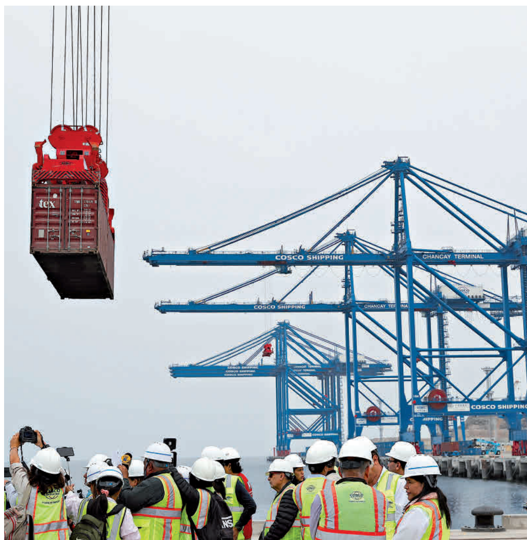
Obras en el puerto de Chancay, en la provincia de Huaral, a unos 80 km al norte de la ciudad de Lima, Perú.
